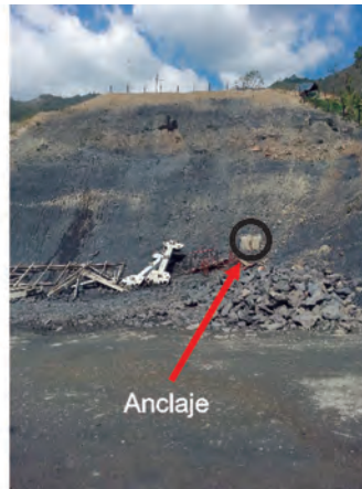
Fotografía 2. Localización del sitio de la prueba de falla.
