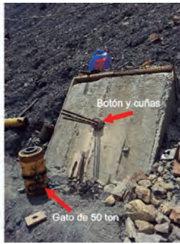
Fotografía 5. Gato hidráulico para la prueba de falla.
