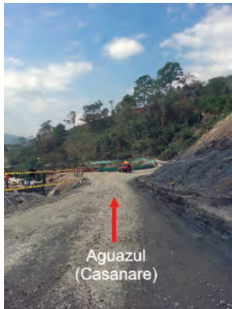
Fotografía 1. Estado de la vía.
