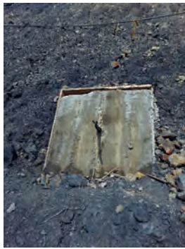
Fotografía 4. Anclaje en tres torones para la prueba de falla.
