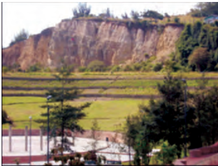
Fotografía 1. Talud norte del Parque Mirador de los Nevados.
