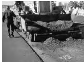
Figura 23. Porciones de mezcla en frente de la pavimentadora (ref. 2).
