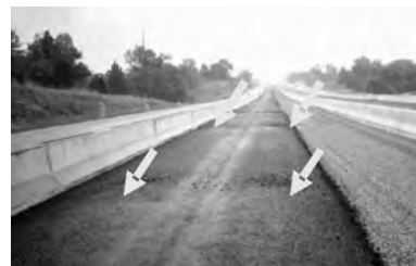
Figura 13. Segregación entre viajes de mezcla (ref. 2).
