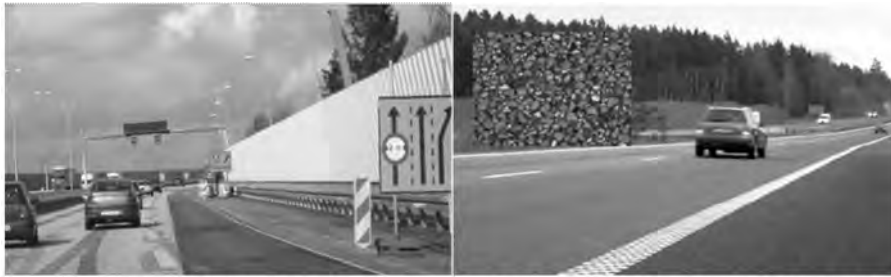
a) Ampliación del anillo vial alrededor de la ciudad de Copenhague (Dinamarca). Capas asfálticas delgadas. b) Sección de ensayo en carretera al norte de Estocolmo. Capas asfálticas porosas.
