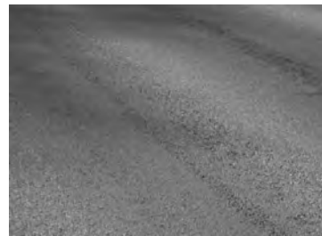
Figura 4. Segregación aleatoria.
