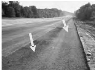
Figura 25. Segregación longitudinal de borde (ref. 2).
