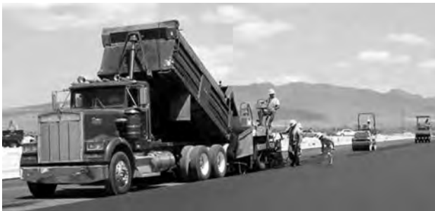
Figura 32. Intervención manual mínima tras la pavimentadora.
