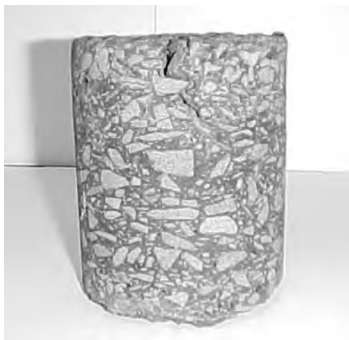
Fotografía 2. Fisuración de arriba hacia abajo (5).
