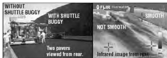
Figura 35. Diferencias de temperatura en franjas de mezcla extendida sin ayuda y con ayuda de un vehículo de transferencia.
