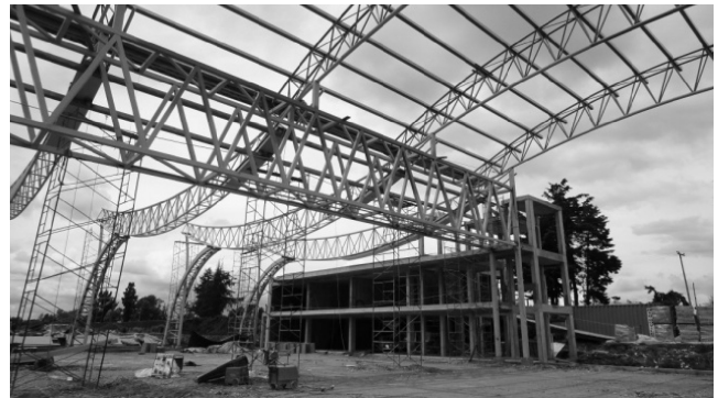
Foto 3. Viga-puente. Configuración general de la estructura.
