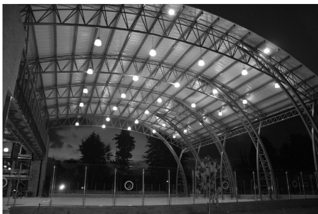
Foto 9. Zona cubierta abierta del coliseo.
