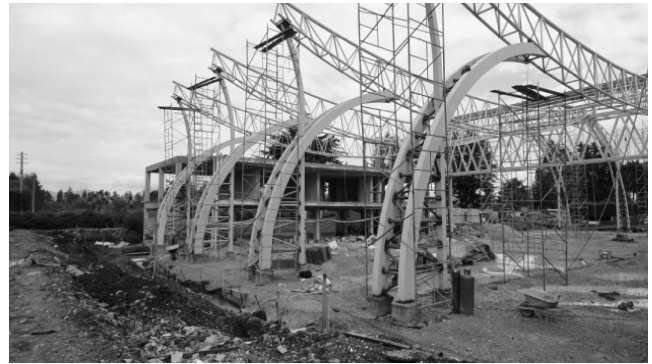
Foto 1. Composición de la estructura metálica. Fachada sur.
