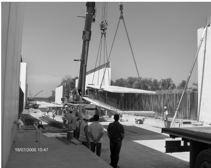
Figura 7. Puesta en obra de la bilastra.
