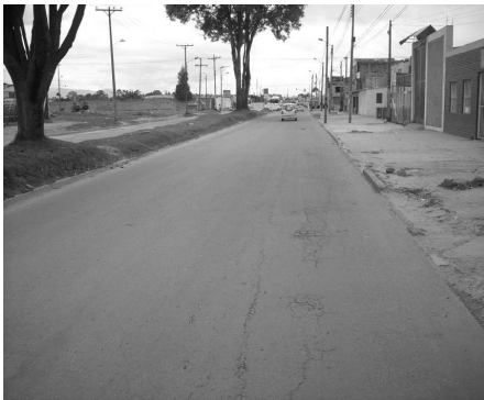
Figura 4. Estado superficial tramo ARW80100.
