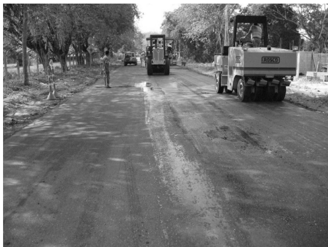
Fotografía 5.6.1 Compactación de capa de mezcla de MOAN con rodillo liso y compactador neumático.
