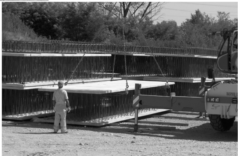
Figura 5. Almacenamiento de la balastra.
