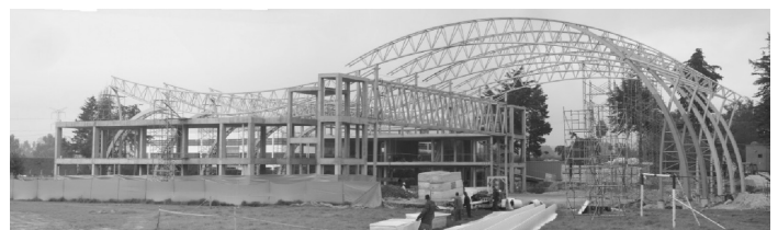
Foto 4. Configuración general de la estructura. Todos los elementos metálicos de las columnas y la cubierta se construyeron en el sitio.
