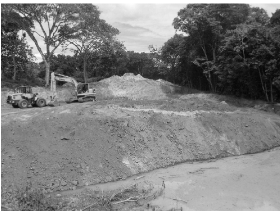
Fotografía 4.1.1 Mina de Isaza .
