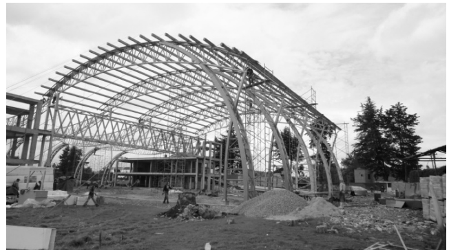
Foto 2. Estructura metálica. Sector nororiental.
