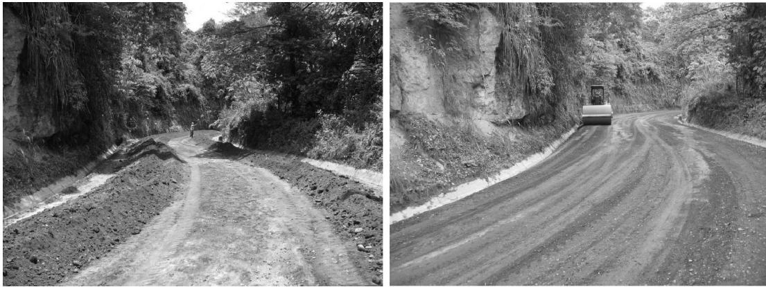
Fotografías 6.2 Capas de base granular estabilizada con MOAN.
