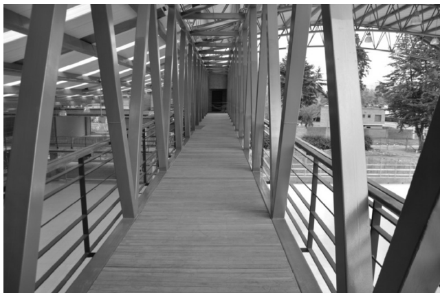
Foto 7. Viga-puente, cuyo diseño y disposición la convierten en pieza clave del coliseo.
