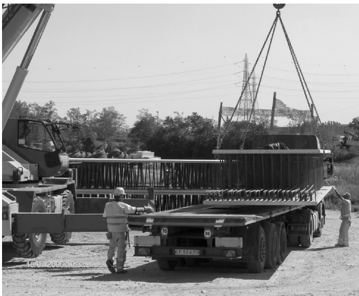
Figura 4. Transporte de la balastra.
