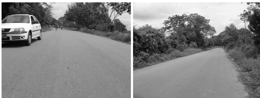
Fotografías 5.6.4 Recubrimiento de 5 centímetros de MOAN, como refuerzo asfáltico.
