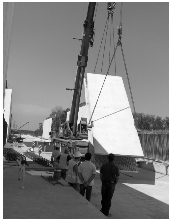
Figura 8. Puesta en obra de la bilastra.
