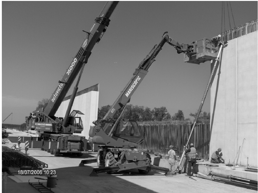
Figura 3. La bilastra estructural.
