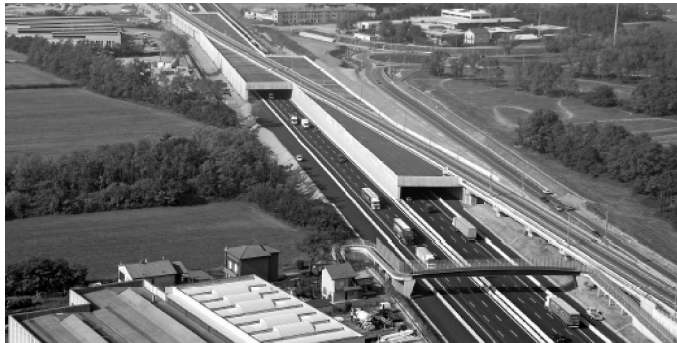
Figura 1. Túnel línea de alta capacidad Turín - Milán.
