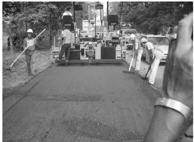
Fotografía 5.5.1 Extendido con finisher de la mezcla de MOAN.
