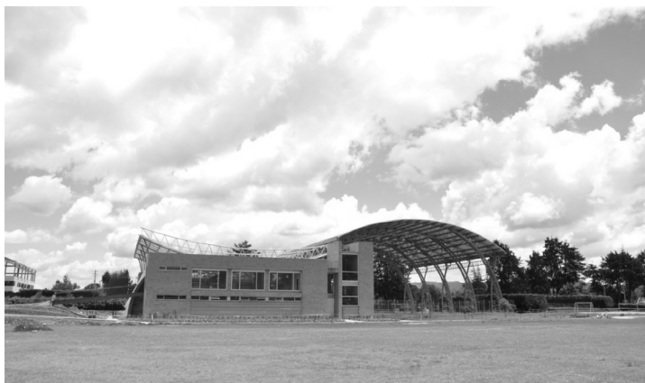
Foto 5. Fachada oriental terminada del coliseo El Otoño.
