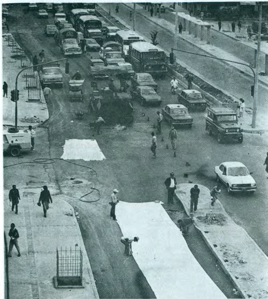
Repavimentación con Geotextiles en la Av. Caracas en Santafé de Bogotá
