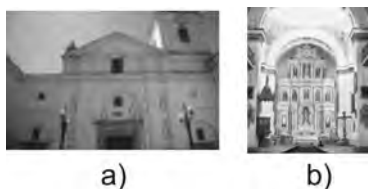
Figura 3. Iglesia de San Ignacio: a) fachada principal; b) vista interna.
