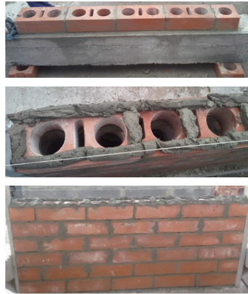
Figura 4. Construcción de los muros.
