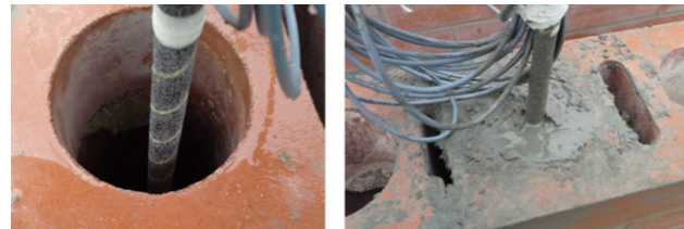
Figura 6. Ubicación de la barra e inyección del mortero de relleno.
