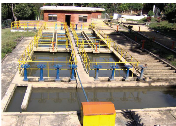
Vista general de la planta de tratamiento.
