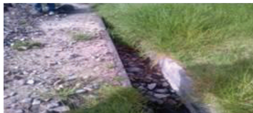
Foto 3. Cuneta en concreto.
