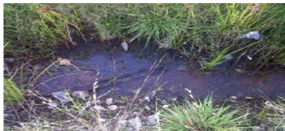
Foto 2. Cuneta en tierra.
