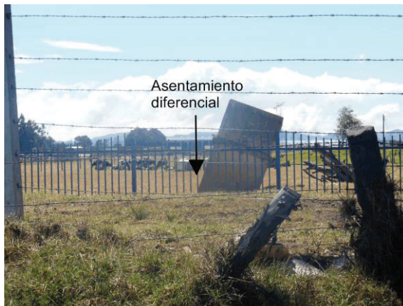
Figura 5. Asentamientos diferenciales producidos en el municipio de Tenjo (Cundinamarca).
