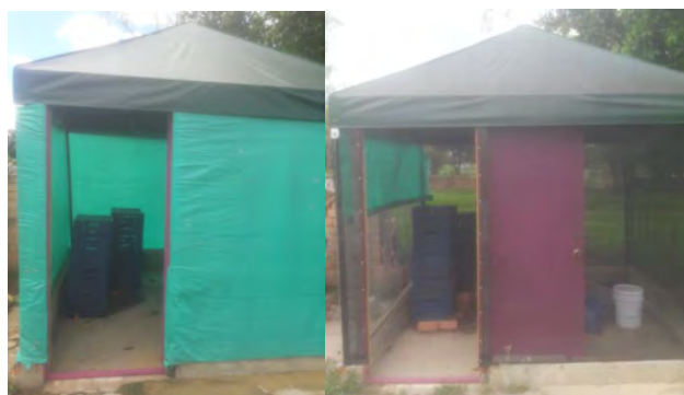
Figura 1. Piloto de compostaje antes y después de adecuaciones del cerramiento.
